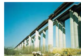
Stura di Demonte Viaduct, Italy
